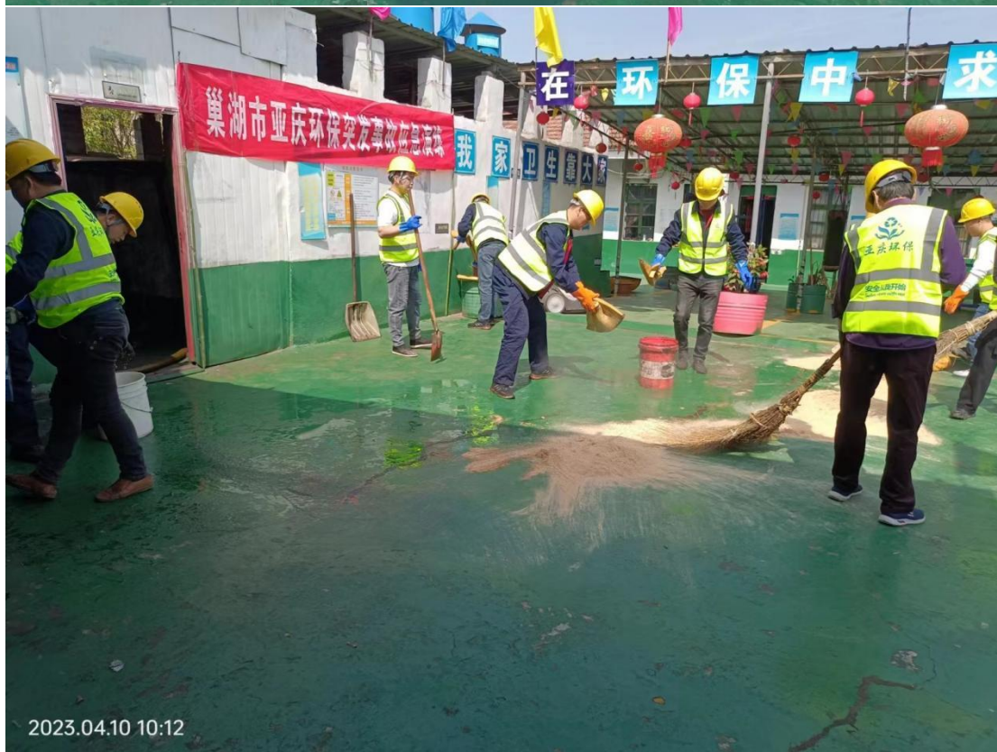
现场残留泄漏物清理
